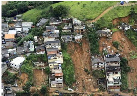
Glissement de terrain au Brésil le 12 janvier 2011
