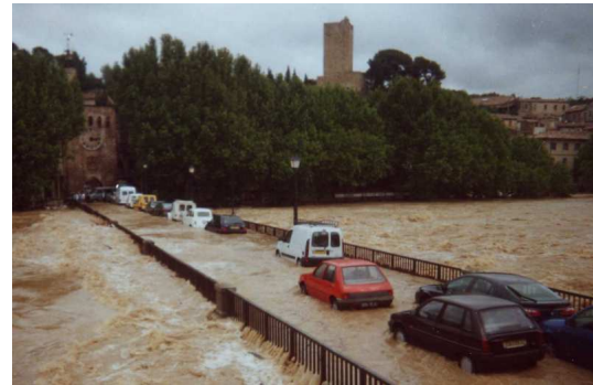
Fig.8 : Le pont romain de Sommières submergé
